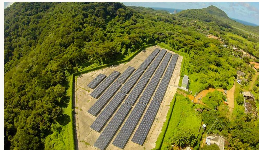
Usina Solar Noronha II (Ilha de Fernando de Noronha), 550 kWp, 800 MWh/ano. Construída em um espelho de captação de água de chuva. Pernambuco
