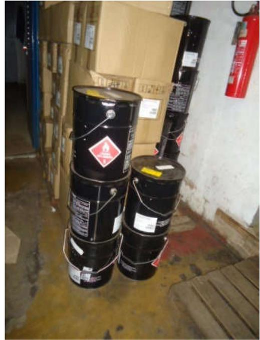
Foto 32: Estoque dos solventes sem contenção
